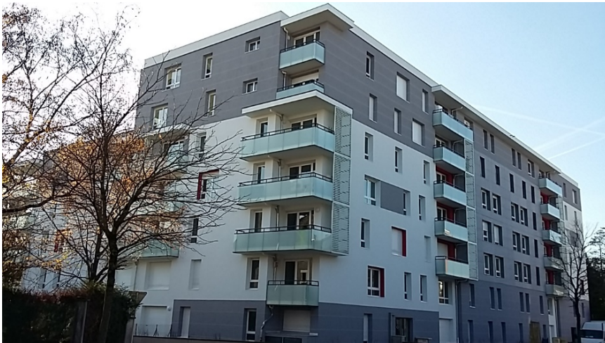
Façade côté rue
